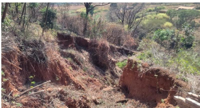
**Erosão 3:** Rua do Mirante, próximo à ch/B30, formada pelo escoamento superficial das águas de chuva
