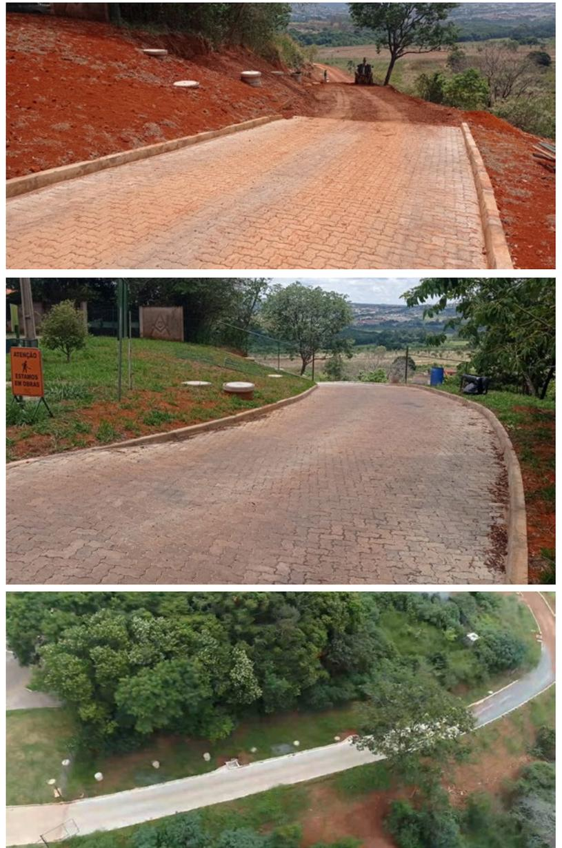
**Rede coletora:** bocas de lobo, caixas de passagem, caixas de recarga e grades de proteção (Microdrenagem).
