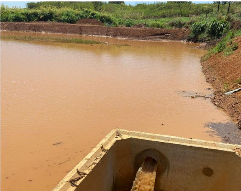
**Dissipadores, vertedores e emissários:** o sistema de drenagem do Antares possui dois dissipadores de concreto e quatro dissipadores de gabião. Possui também duas caixas vertedoras e dois emissários, sendo um ligado ao reservatório e outro ligado à barragem.
