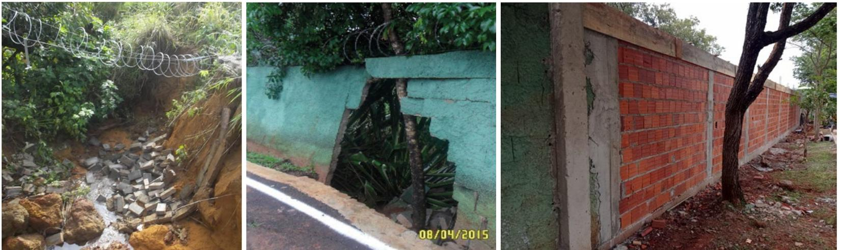
Muros danificados ou derrubados em decorrência do acúmulo das águas pluviais que não tinham como escoar
