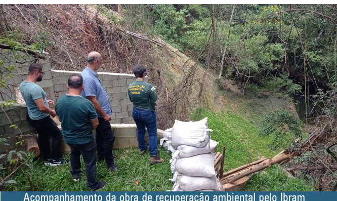
Acompanhamento da obra de recuperação ambiental pelo IBRAM
