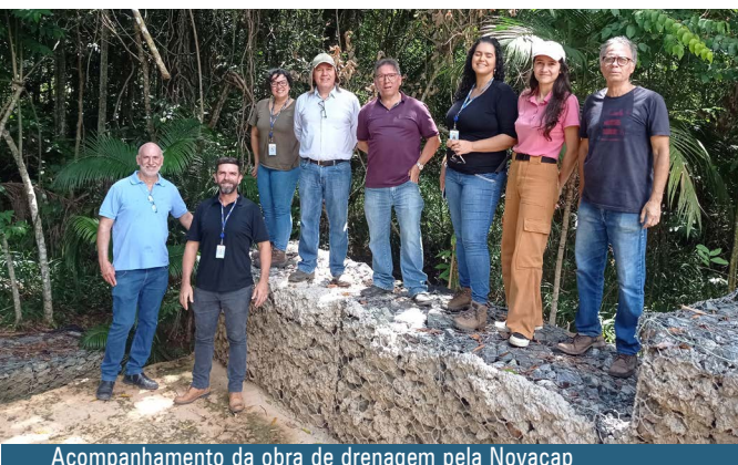
Acompanhamento da obra de drenagem pela Novacap
