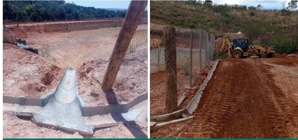
Detalhes finais obra de drenagem, proteção das bacias de contenção, paliçadas e bocas de lobo
