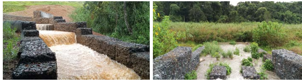
Detalhes finais obra de drenagem, proteção das bacias de contenção, paliçadas e bocas de lobo
