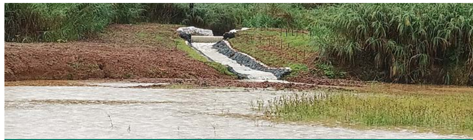
Lançamento final das águas pluviais
