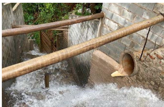
Escada hidráulica da Rua do Mirante
