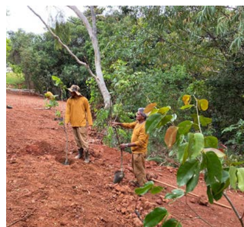
Plantio de mudas na área da erosão 2
