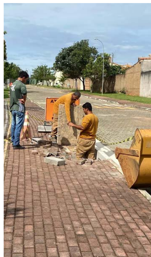
Abertura de bocas de lobo na Rua do Lazer
