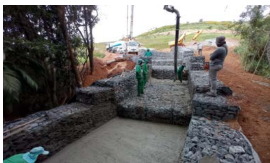
Dissipador de gabião para lançamento da água no córrego Capão Grande
