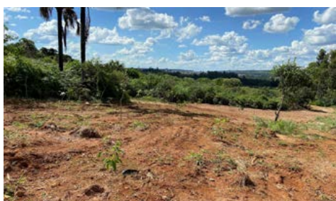
Erosão 4 recuperada e revegetada
