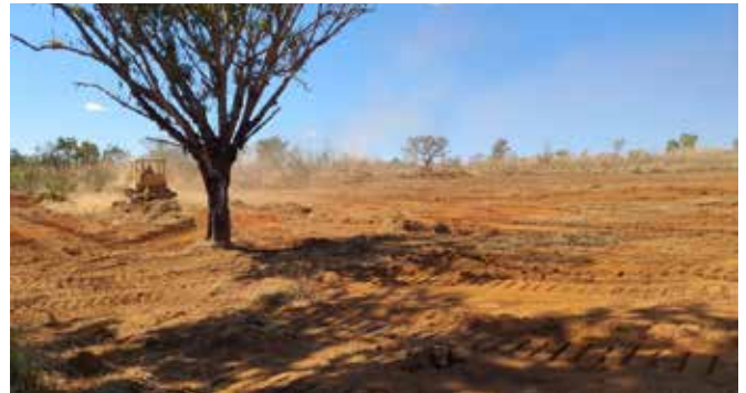
Finalização da topografia, sondagem e limpeza da área para a escavação da bacia de contenção e construção da galeria de concreto armado
