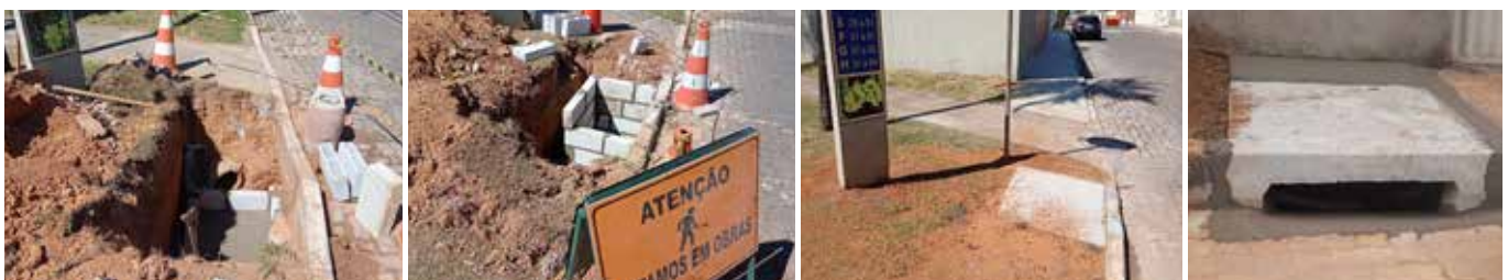
Construção das caixas coletoras (bocas de lobo) na área interna do condomínio, que serão abertas após a conclusão da obra de macrodrenagem
