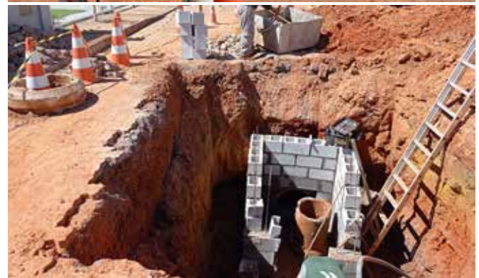
Recuperação de posto de visita da rede secundária interna
