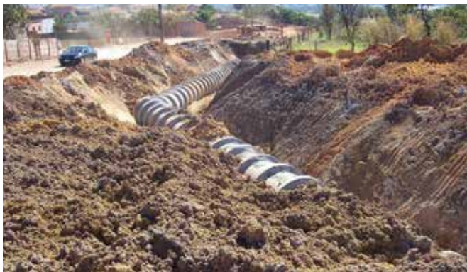
Construção da microdrenagem (rede interna). Rua do Mirante 2007
