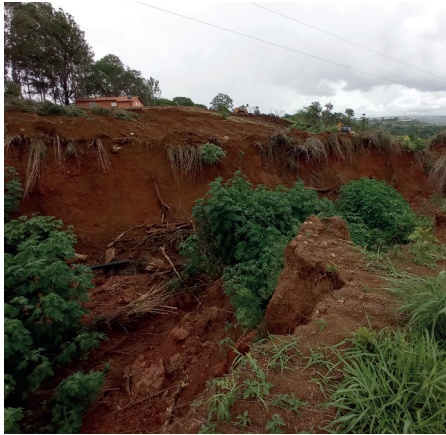
Recuperação da erosão 5. Após a construção da galeria de 1,65 x 1,65m foi feito o reaterro da área da obra e da erosão para fazer o plantio de árvores e gramíneas
