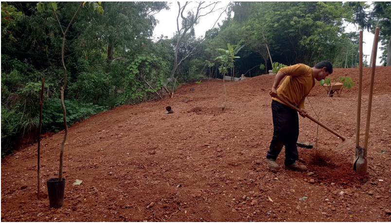
Recuperação das erosões 1 e 2. Reaterro, plantio de árvores e gramíneas
