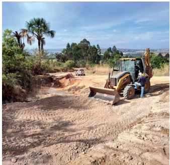
Recuperação da erosão 4. Com a abertura da rede Centauros foi possível fazer a recuperação da erosão com reaterro e plantio de árvores e gramíneas
