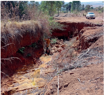
Recuperação da erosão 4. Com a abertura da rede Centauros foi possível fazer a recuperação da erosão com reaterro e plantio de árvores e gramíneas
