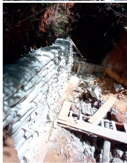
Erosão 2 - Trabalho de recuperação das encostas da erosão com paliçadas e rip-rap. Concretagem do fundo do canal para evitar futuras erosões
