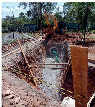
Adequação da rede interna para interligação com a rede externa
