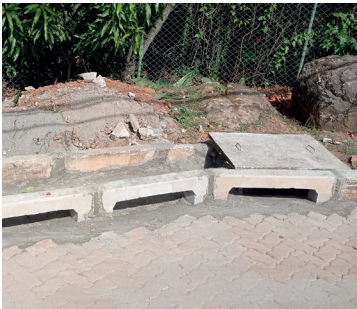
Melhorias nas captações da rede de microdrenagem com aberturas de novas bocas de lobo e melhorias das existentes
