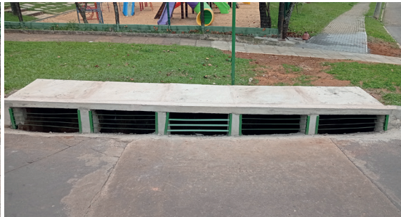
Melhorias nas captações da rede de microdrenagem com aberturas de novas bocas de lobo e melhorias das existentes
