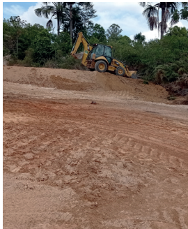
Recuperação da erosão 4. Com a abertura da rede Centauros foi possível fazer a recuperação da erosão com reaterro e plantio de árvores e gramíneas
