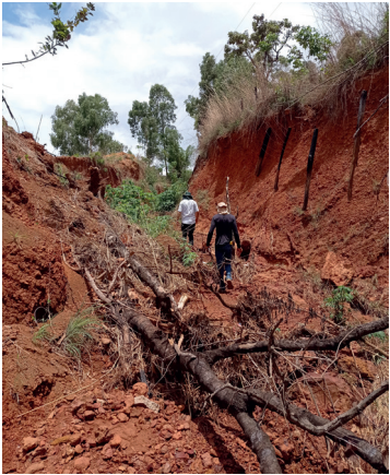
Recuperação da erosão 5. Após a construção da galeria de 1,65 x 1,65m foi feito o reaterro da área da obra e da erosão para fazer o plantio de árvores e gramíneas
